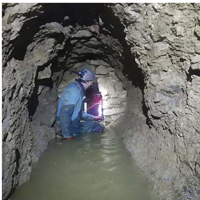
Aqueduc souterrain d'alimentation en eau (Condat-sur-Vienne, Haute-Vienne)
