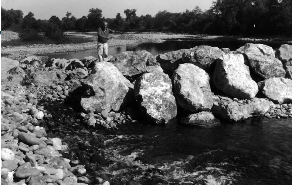
Vue du barrage d'Auterrive, le 5 septembre 1994. Il sera démoli sur décision du Conseil d'Etat le 22 octobre 2003.
