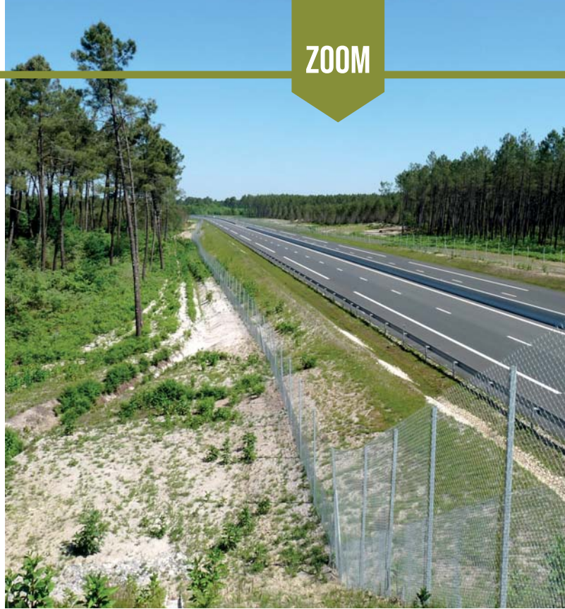
Les enclos privés s'ajoutent aux clôtures d'autoroutes et de LGV...
