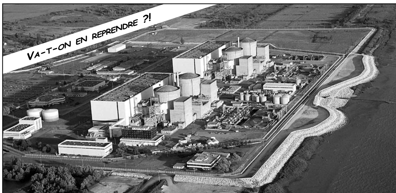
Centrale nucléaire du Blayais
