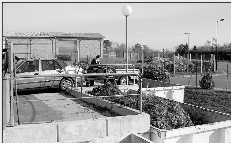
A gauche : Incinérateur de Bègles - Ci-dessus : Déchetterie
