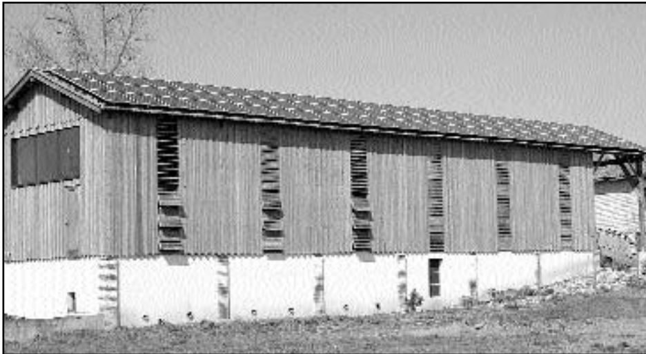
105 m 2 de panneaux solaires photovoltaïques pour 15.000 kW d'énergie propre
