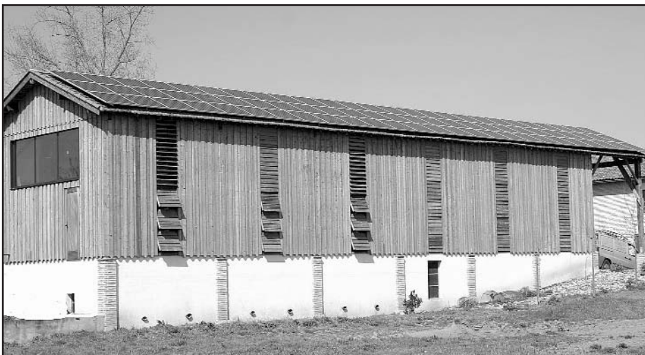
105 m 2 de panneaux solaires photovoltaïques
