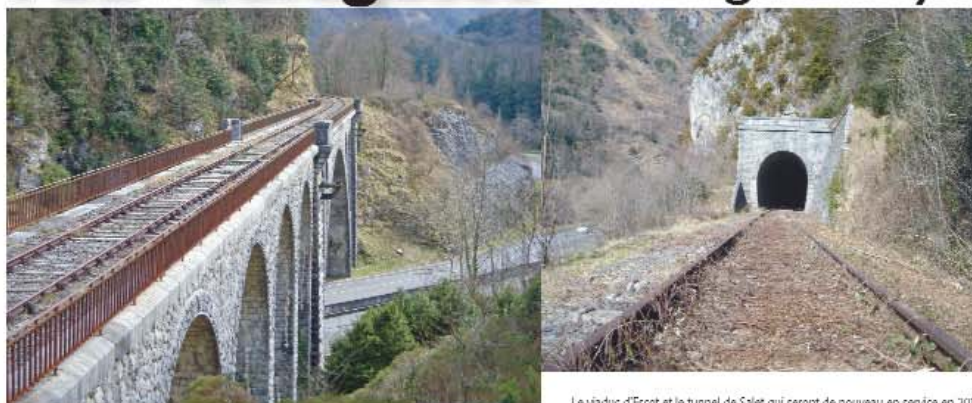
Le viaduc d'Escot et le tunnel de Salet qui seront de nouveau en service en 2010
