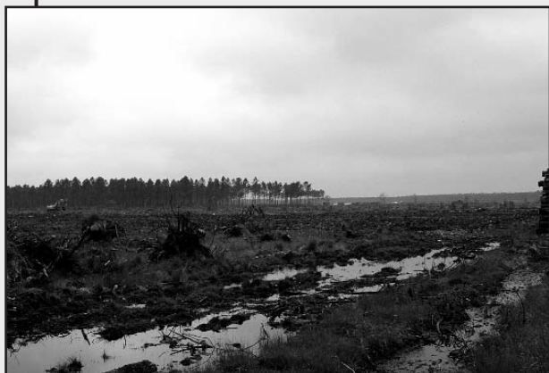
▲ En haut : la zone défrichée. Au loin, on devine le chantier... 300 hectares, c'est immense !
