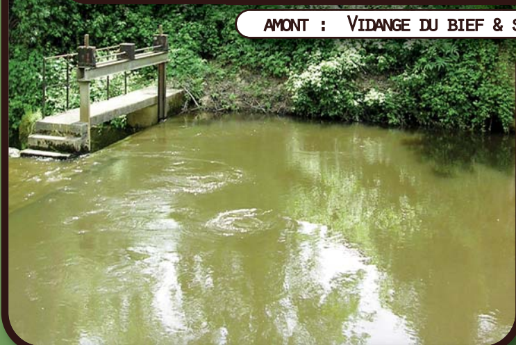
AMONT : MODIFICATION DES ÉCOULEMENTS (ABAISSEMENT DE LA LIGNE D'EAU & RECHENALISATION DU CIRON)
