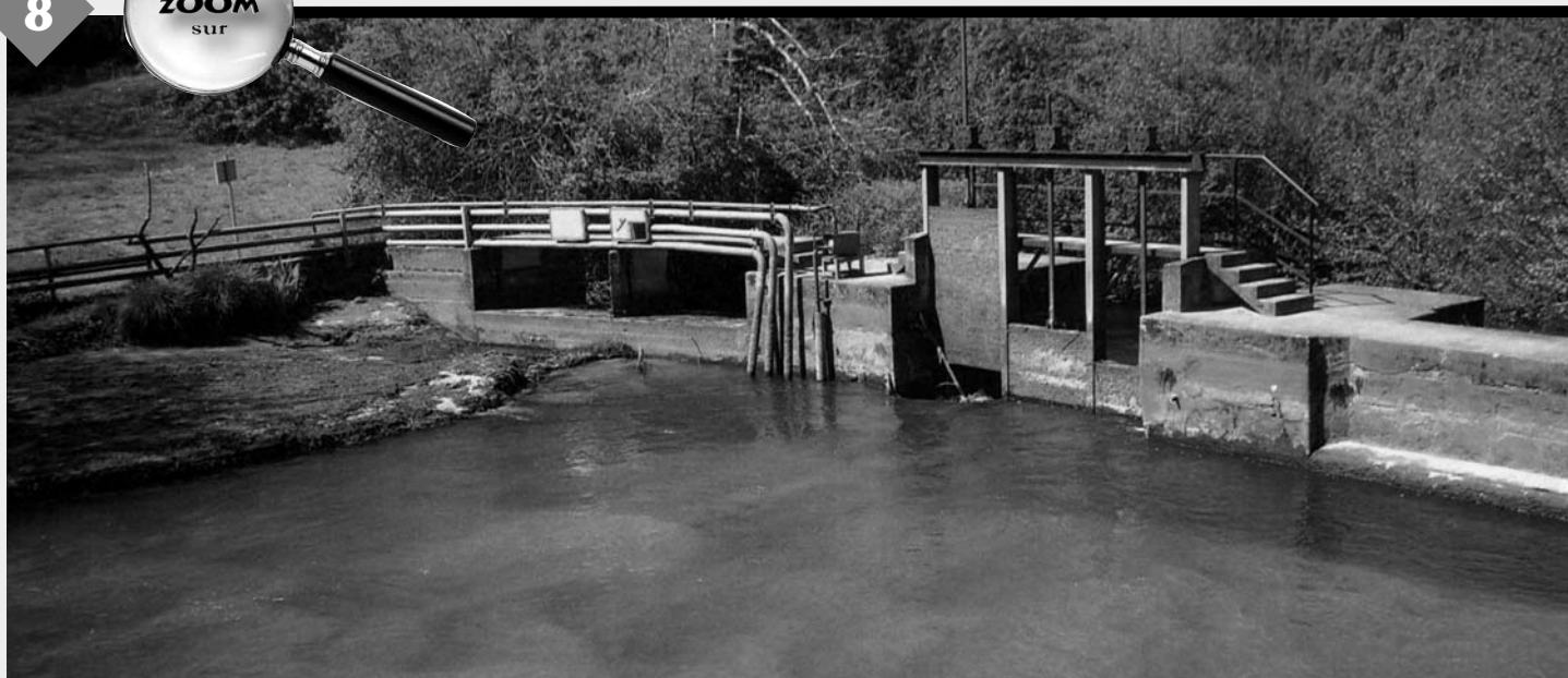
Amont de l'ouvrage du Moulin de Tierrero à Beaulac : avant ouverture des vannes
