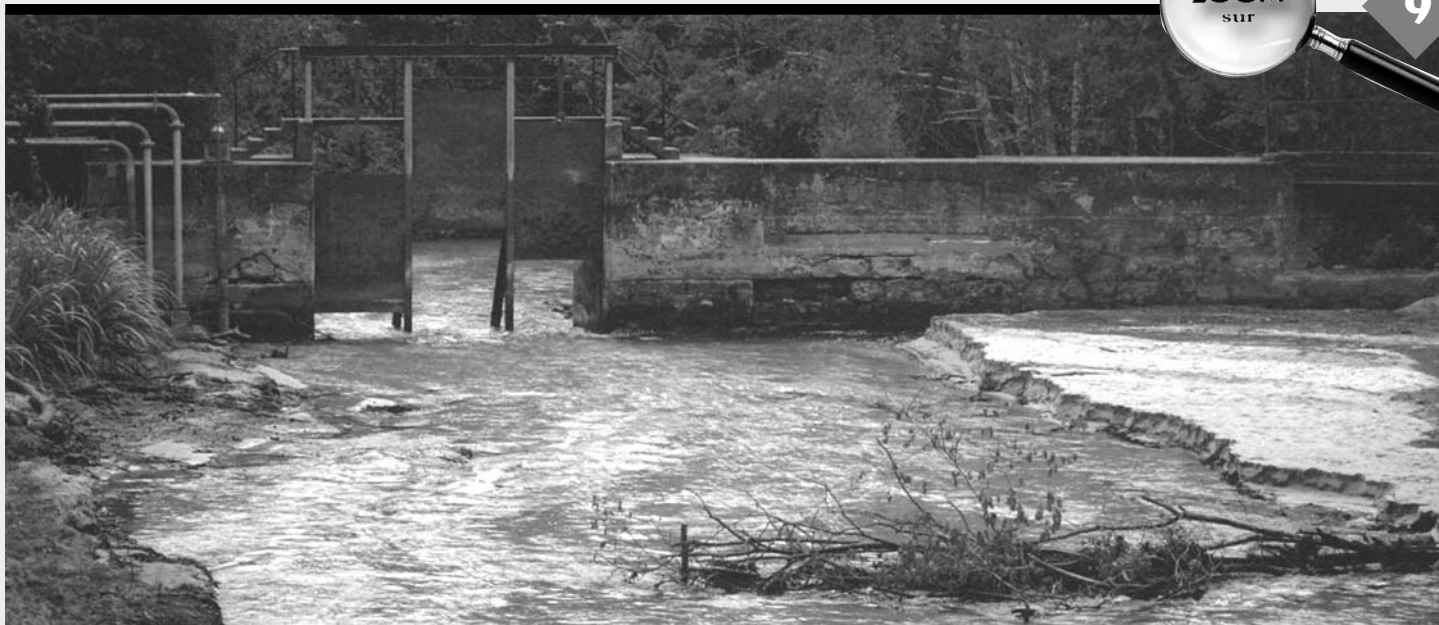
Amont de l'ouvrage du Moulin de Tierrero à Beaulac : après ouverture des vannes
