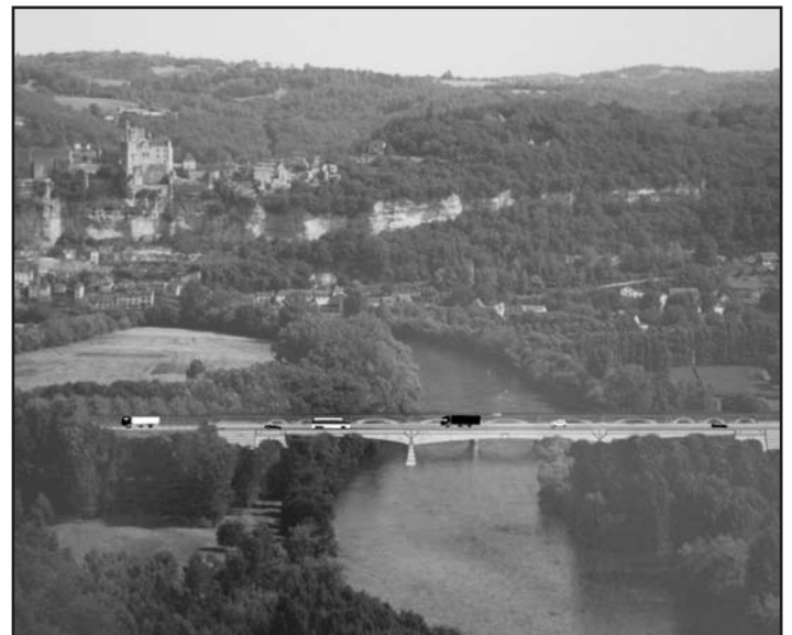
Paysage probable après la construction du 2 ème pont (simulation) ▲
