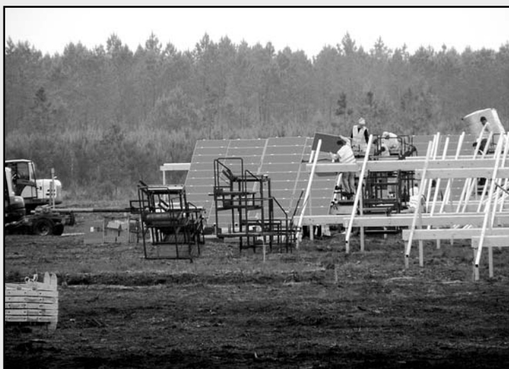
Les chantiers de centrales photovoltaïques s'enchaînent à un rythme fou.
