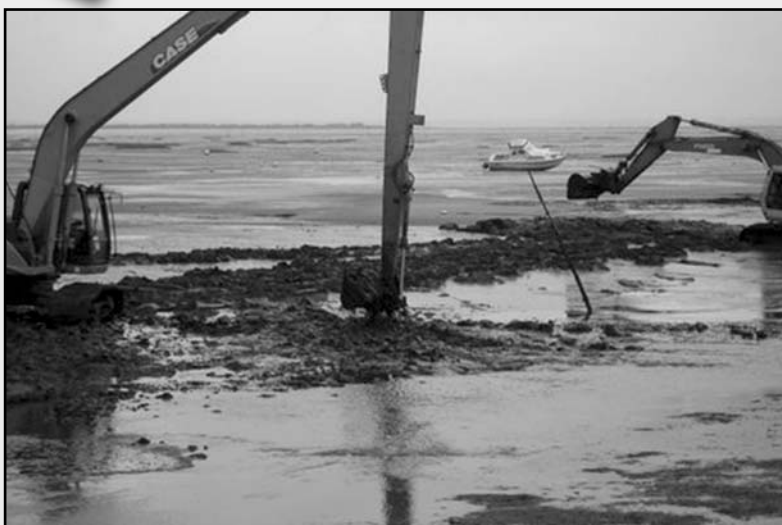
Dragage du chenal d'accès à un port
