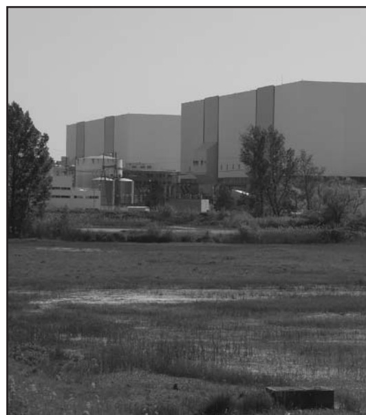
▲ La "réserve" située à proximité de la centrale nucléaire
