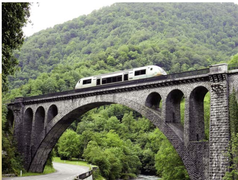
Le viaduc d'Escot surplombe le gave d'Aspe. Il date de 1909 et l'arche centrale fait 56 m de long. Nous sommes à 16 km au sud d'Oloron. L'autorail Pau-Bedous circule à nouveau depuis le 2 juillet 2016.
