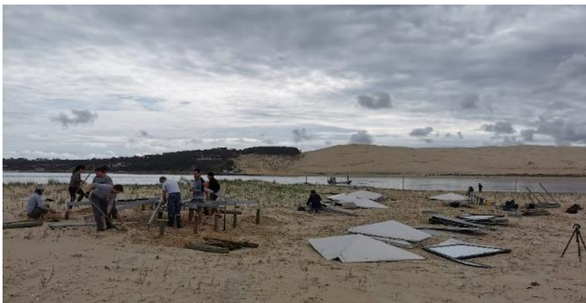
Figure 38 : Montage de la cabane d'hébergement en mai 2025
